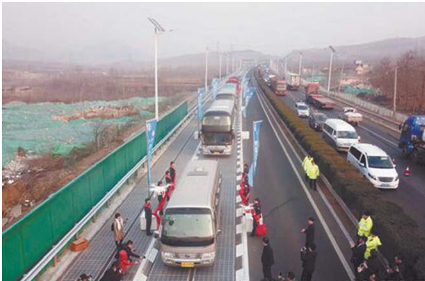
2017年12月28日,车辆在承载式光伏高速公路上行驶。当日,我国首个承载式光伏高速公路试验段在济南建成通车。
